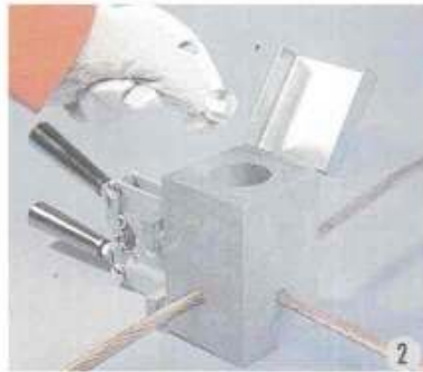
Metal diski kalıp haznesinin içine yerleştirin
