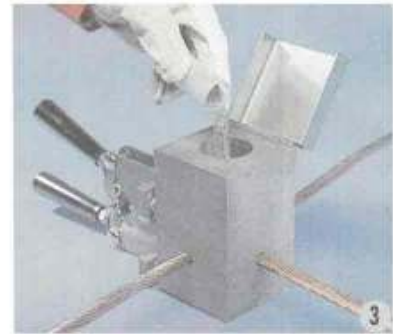
Tozu hazneye boşaltın ve üzerine başlatma tozunu serpiştirin
