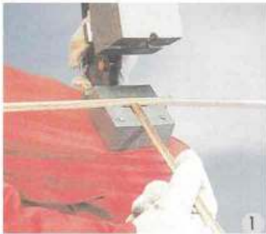
Kaynak yapılabilmesi için kalıbın kuru ve temiz olduğundan emin olduktan sonra iletkenleri kalıbın içine yerleştirin.
