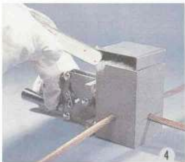
Kapağı kapatın ve yan delikten çakmak ile başlatma tozunu ateşleyin
